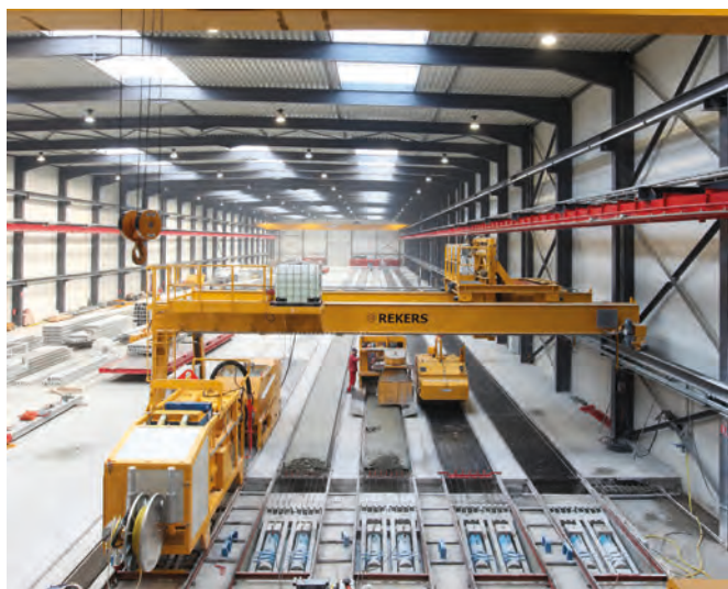
Capannone di produzione presso lo stabilimento di Malle
